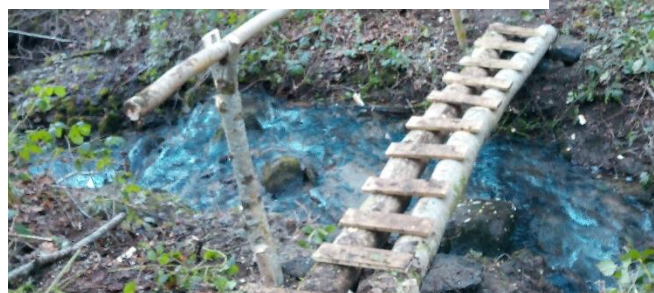
Nouvelle passerelle sur le ruisseau des Combes de mort
